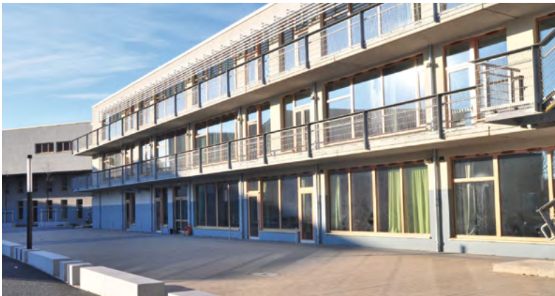
Abb. 37 Ostfassade im Innenhof
