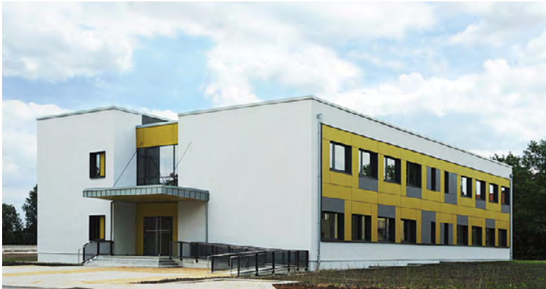
Abb. 33 Nordeingang und Westfassade
