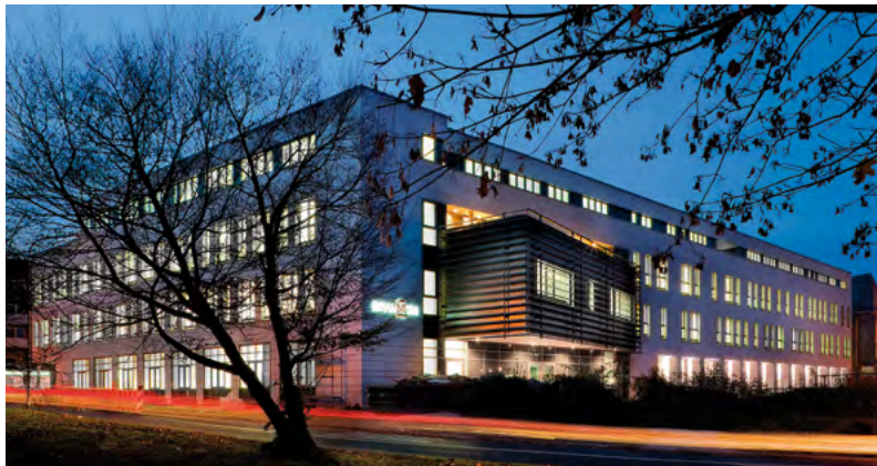
Abb. 45 Südostecke mit Eingangsbereich
