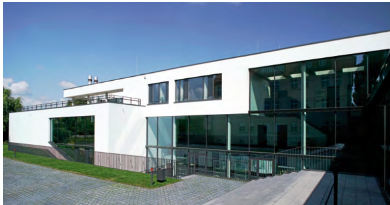
Abb. 40 Blick vom Verbindungstrakt auf die Südfassade
