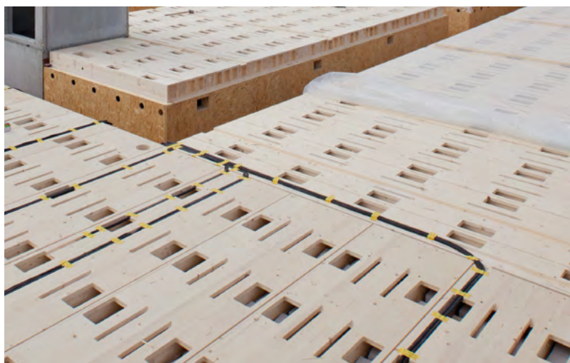
Abb. 28 Leicht trennbare Deckenkonstruktion ohne feste Verbindungen
