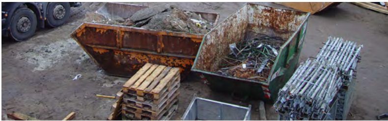
Abb. 31 Trennung von Baustellenabfällen
